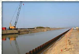
●北上運河・東名運河 野蒜港への舟運のため、明治初期に掘削された運河ですが、現在は第2防冲堤として両岸を整備中です。
