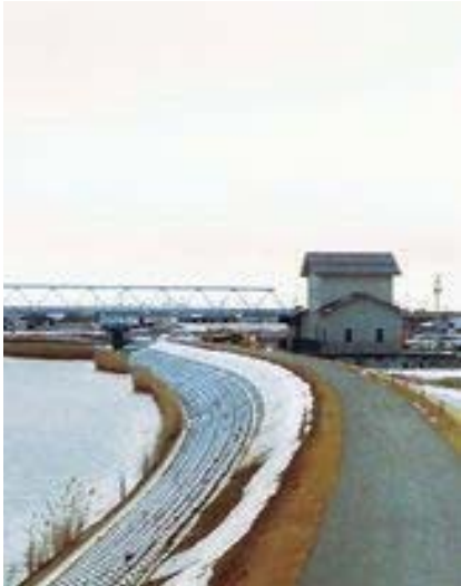
▲下水道管渠工事、五味倉排水区(議案第 133 号)
