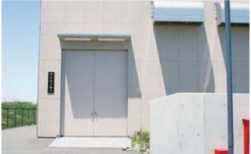
▲調整池等工事、南区排水機場(議案第 132 号)
