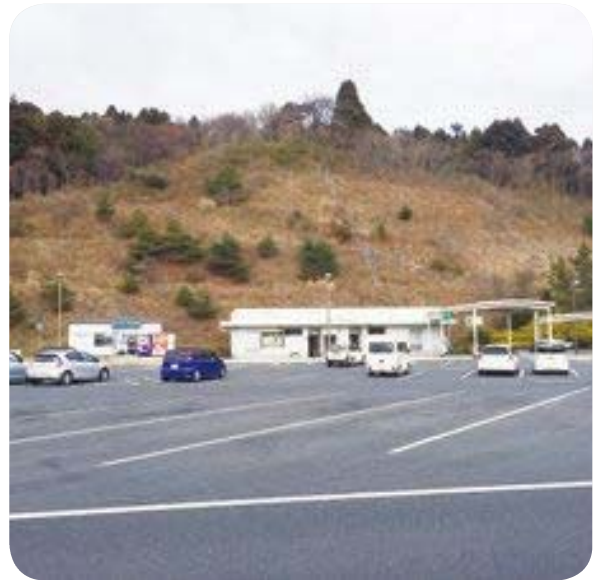
▲今後の活用法が検討されている矢本パーキング
