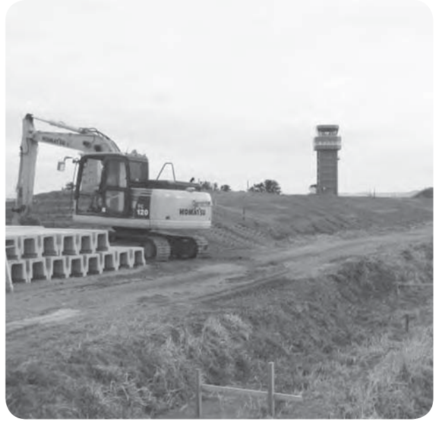
▲高上げ事業が進む立沼地区
