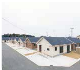
▲小松沢田前地区災害公営住宅
