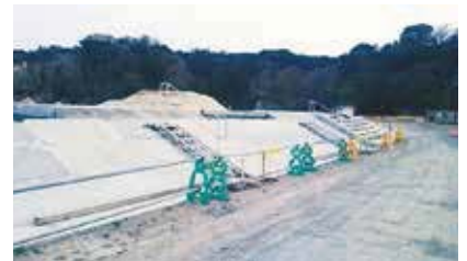
▲月浜漁港海岸施設災害復旧工事
