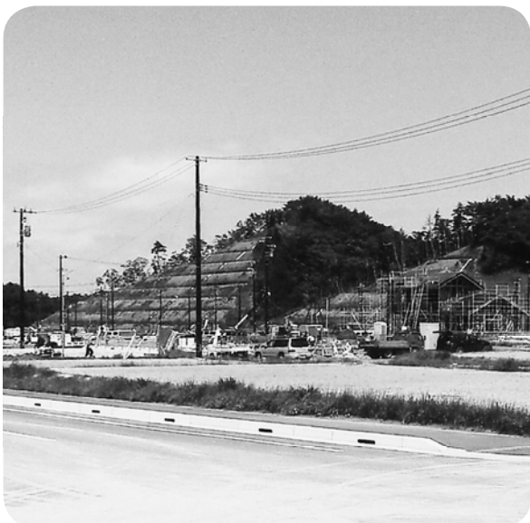
▲野蒜団地 引き渡しされた区画には新築が始まっている
