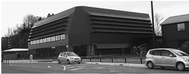
▲野蒜小災害復旧工事により建設された宮野森小体育館
