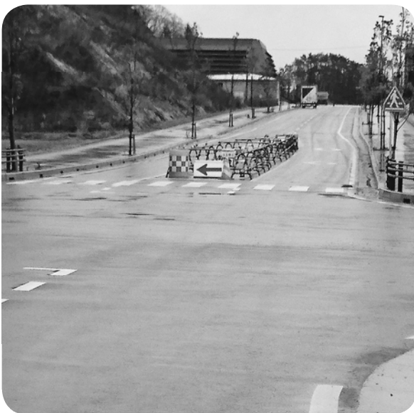
▲安全対策が待たれる市道野蒜ヶ丘1号線
