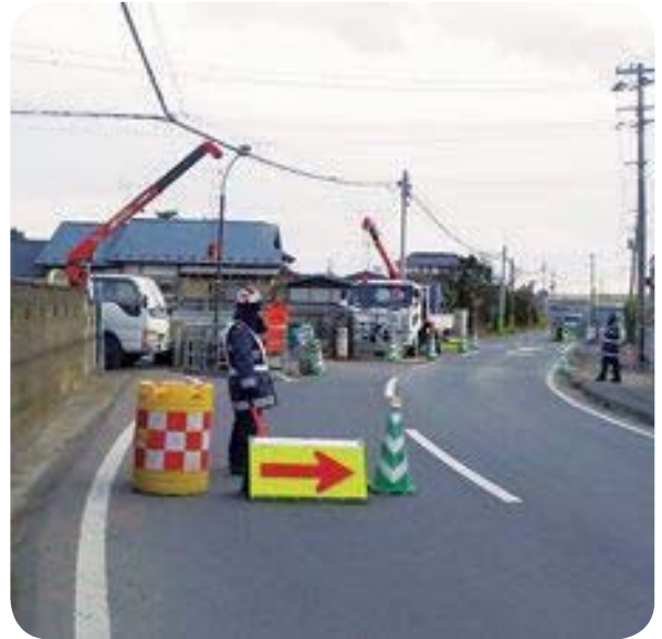
▲赤井川前線流域下水道の工事現場
