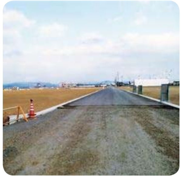
▲整備が進む大曲工業団地
