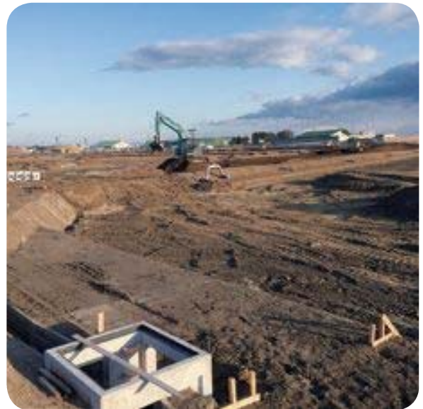
▲西矢本地区のほ場整備事業の様子
