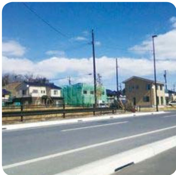
▲完成した野蒜ヶ丘の住宅建築ラッシュ
