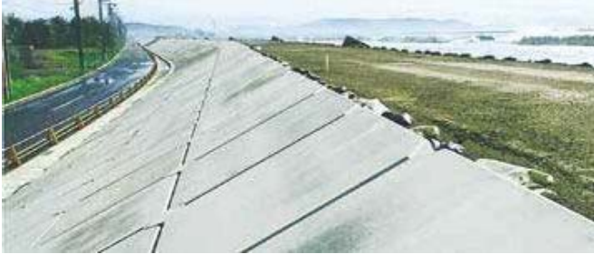
▲完成間近い大曲浜防潮堤
