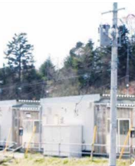
▲平成31年度までに被災者の再建にあわせて解体
