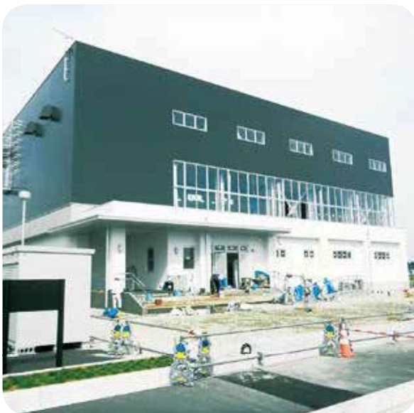
▲あおい地区北に、建設された体育館
