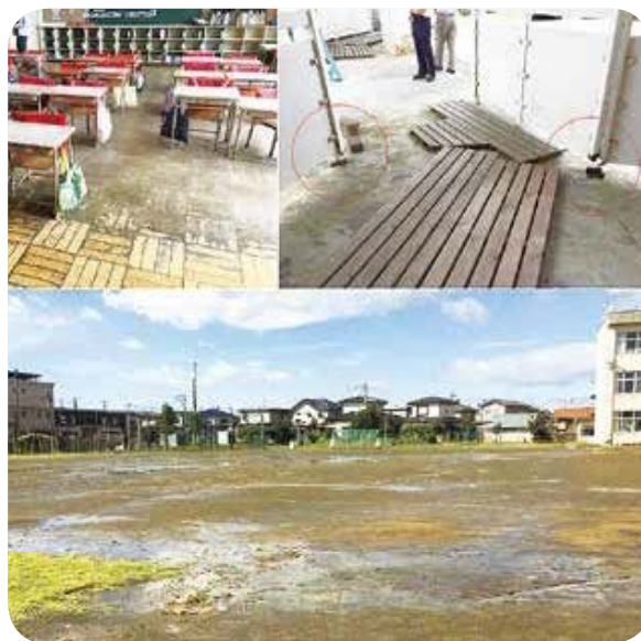
▲今もなお、取り残されている大曲小学校の被災施設
