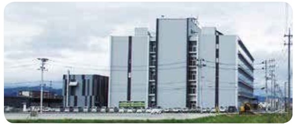
▲柳の目北地区市境、石巻合同庁舎とめぐみ野市街地
