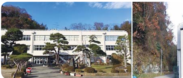
▲土石流発生の危険がある大塩小学校
