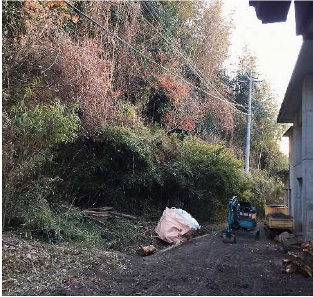
▲大塩小学校北側斜面は、12月下旬から調査業務着手
