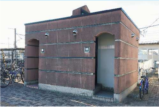
▲段差のあるJR矢本駅前公衆トイレ
