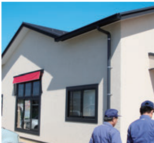
▲小野地域ふれあい交流館（現場視察を実施） にぎわい創出が期待される
