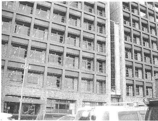
【都城市役所・庁舎】
