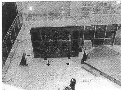
【1階のエントランス部分のをぞむ】
