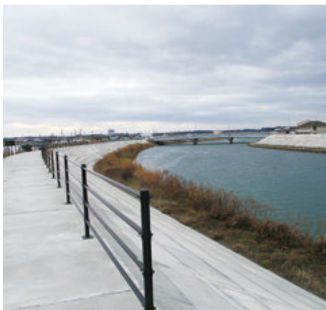
▲定川の両岸のかさ上げ整備事業が完成する。国道45号線付近
