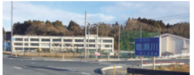
▲利用が検討されている旧鳴瀬未来中学校施設および敷地
