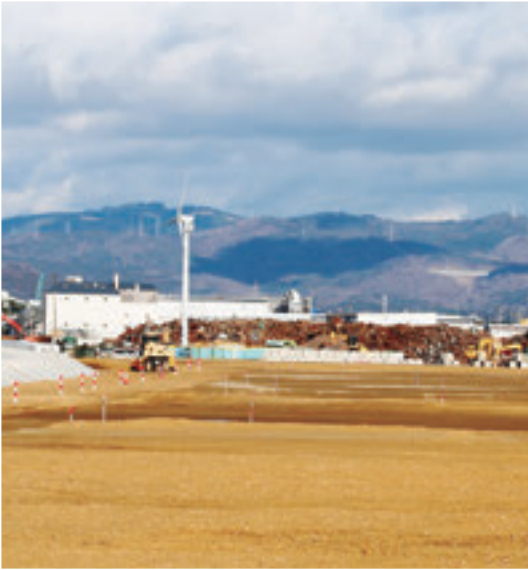
▲来春のオープンに向けて建設工事が進行中 (平成30年12月、上浜橋より撮影)
