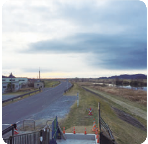
▲小野歩道橋から見た鳴瀬川堤防
