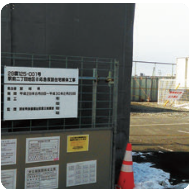
▲解体中の小野駅前応急仮設住宅
