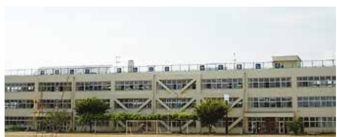
▲冷房機が設置される大曲小学校
