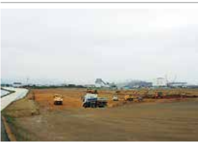
▲着々と建設工事が進行中 (平成30年6月、上浜橋より撮影)
