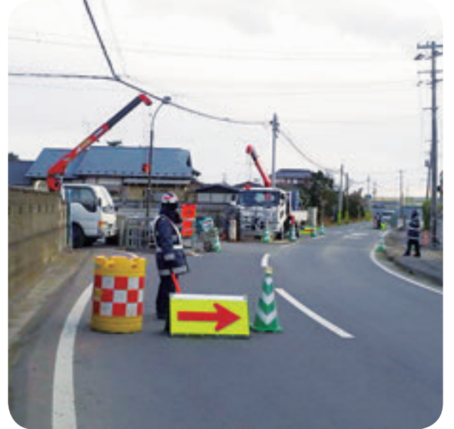
▲赤井川前線流域下水道の工事現場
