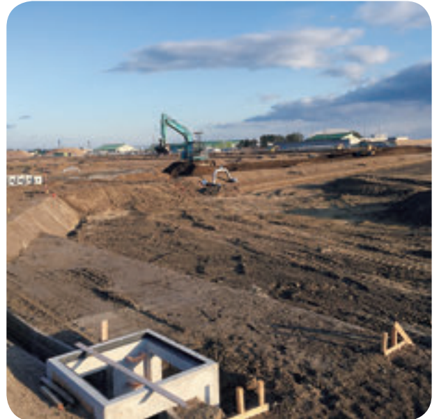
▲西矢本地区のほ場整備事業の様子
