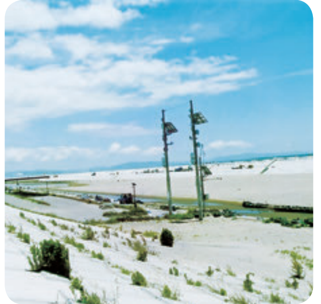
▲堆砂により使用不能となっている浜市漁港
