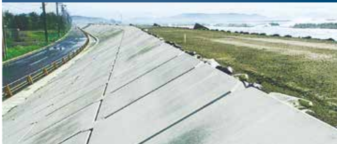
▲完成間近い大曲浜防潮堤
