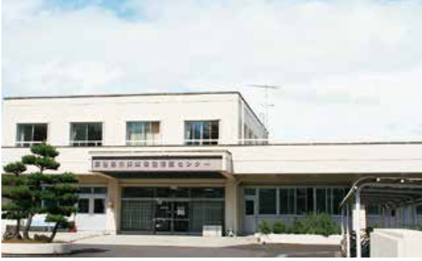
▲改修により利用環境改善が望まれる保健相談センター
