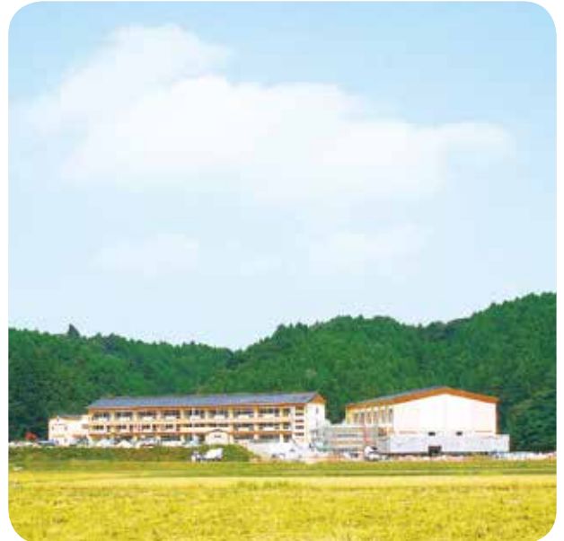
▲新鳴瀬未来中学校は、野蒜中下地区に急ピッチで建設中
