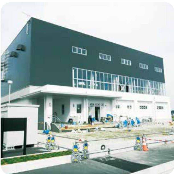
▲あおい地区北に、建設された体育館
