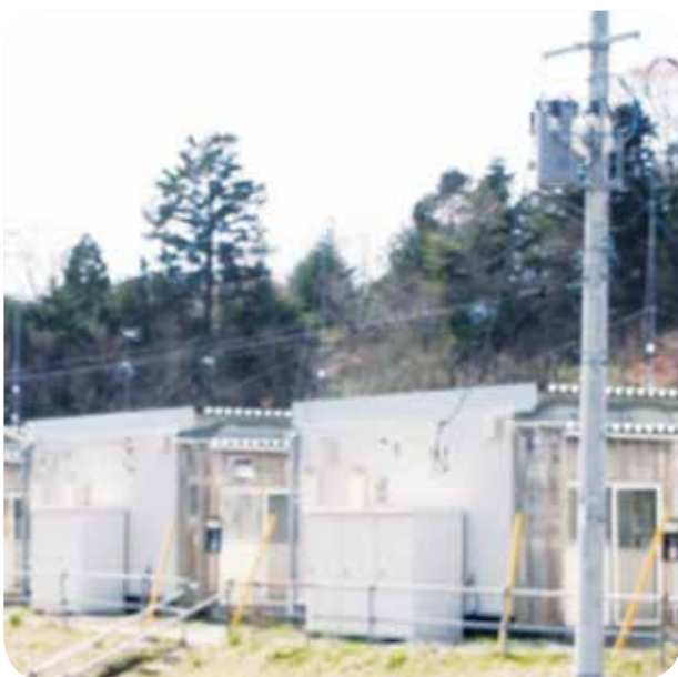
▲平成31年度までに被災者の再建にあわせて解体
