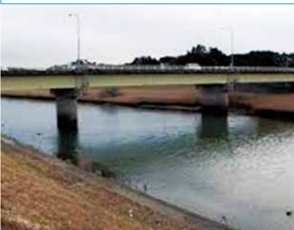
▲道路橋梁等の長寿命化対策を万全に！
