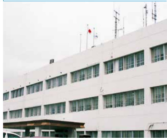
▲老朽化した市役所本庁舎
