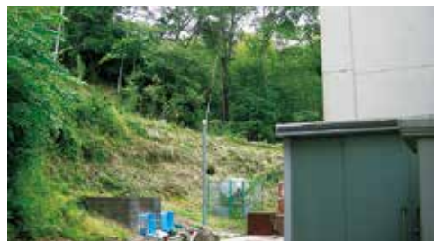
▲令和4年度末に砂防堰堤が完成予定の大塩小学校裏山
