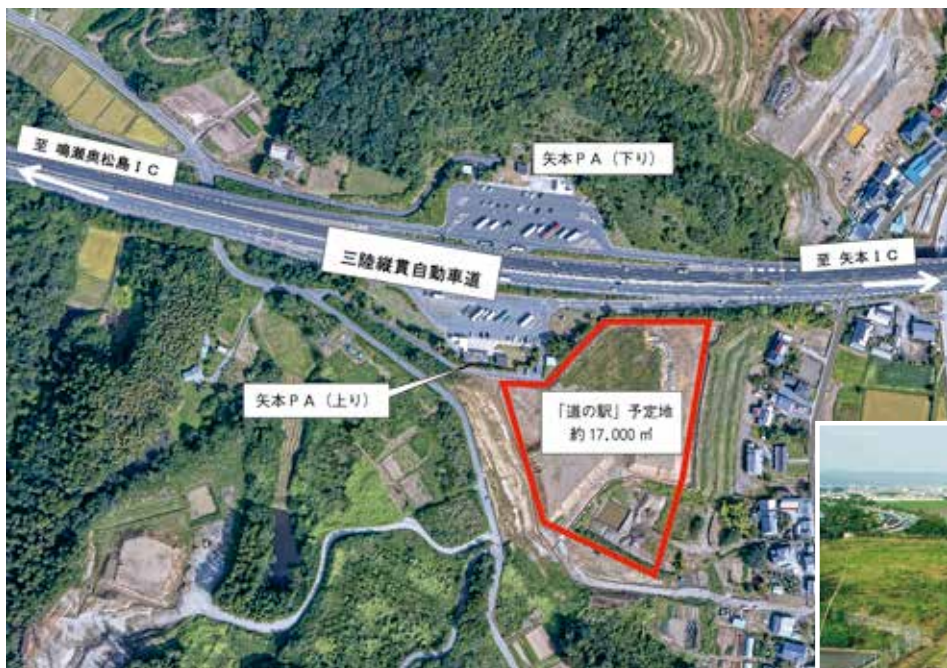
▲道の駅整備予定地航空写真
