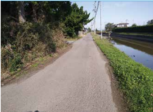
▲拡幅整備が待たれる市道関の内・東54号線
