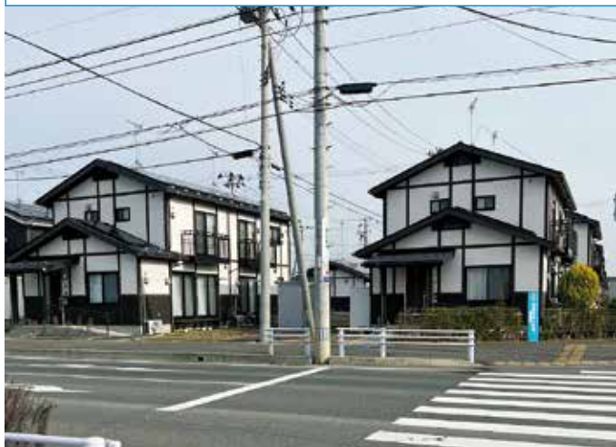
▲被災者の家賃3割減免が期待される災害公営住宅
