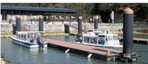
▲完成した奥松島浮棧橋船舶乗場
