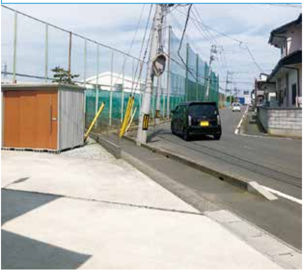
▲傾いている電信柱。安全対策が求められる。
