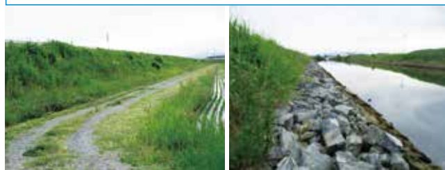
▲津波対策大丈夫か。高盛土道路、嵩上げ堤防等
