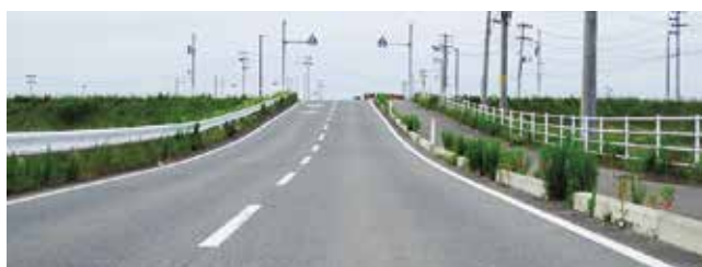
▲新津波浸水想定時の避難のため、整備が待たれる南北避難道路
