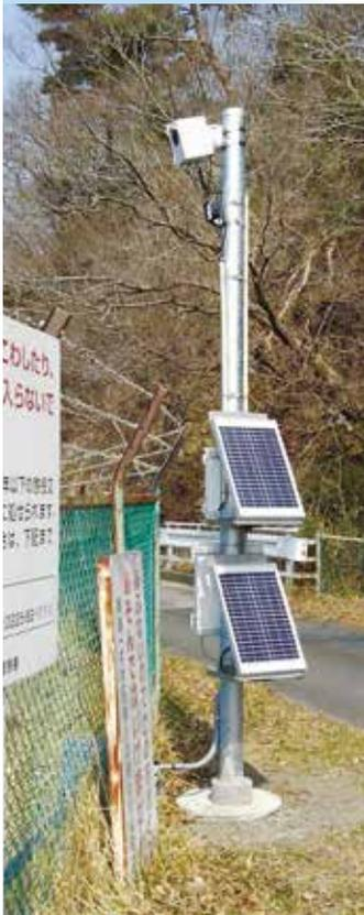
▲牛網堤ため池監視カメラと水位計
