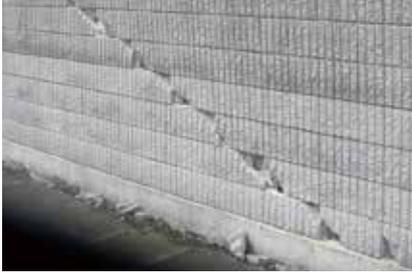
▲亀裂が入り倒壊の恐れがあるブロック塀
