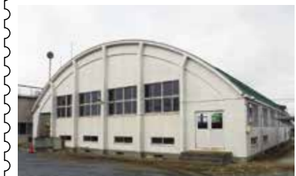
▲東松島市武道館解体前写真
