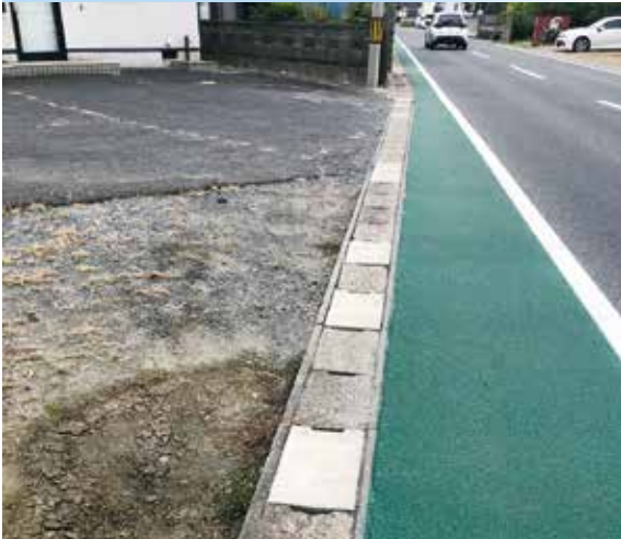
▲現在の歩道の未整備区間
