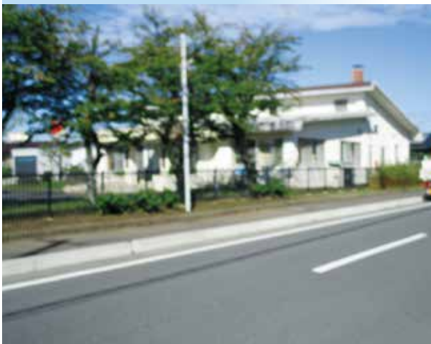
▲冷房設備設置が待たれる学習等共用施設
