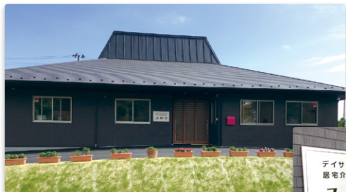
デイサービスセンター みのり
