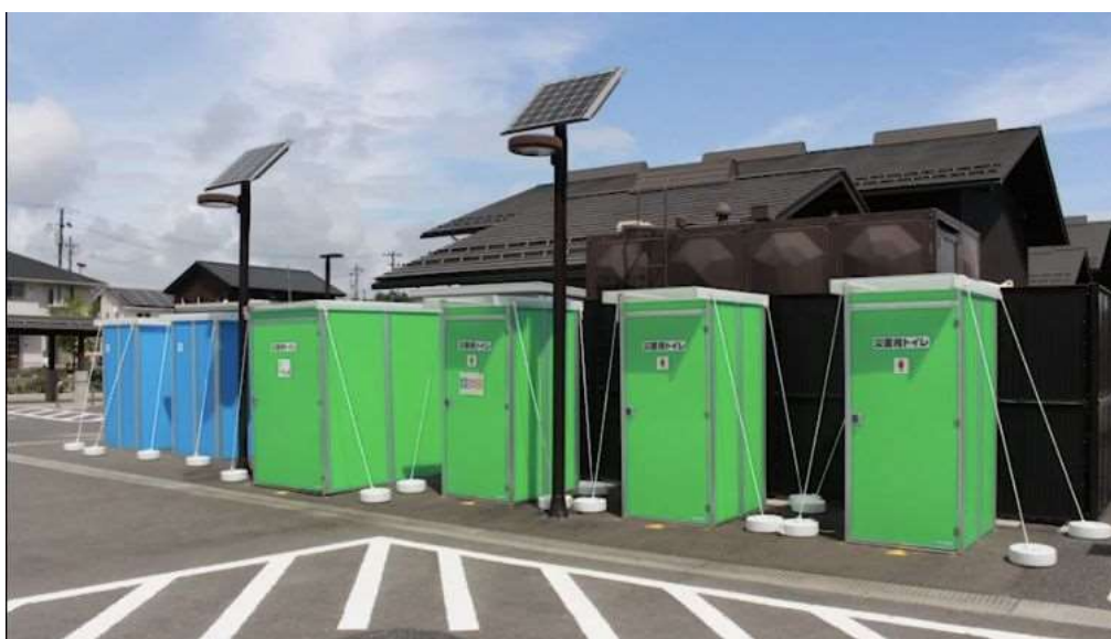
写真－1 マンホールトイレ全景(野蒜市民センター)
