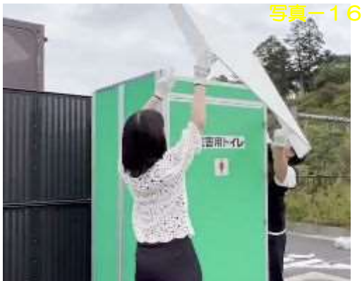
前後を確認して屋根を載せる
