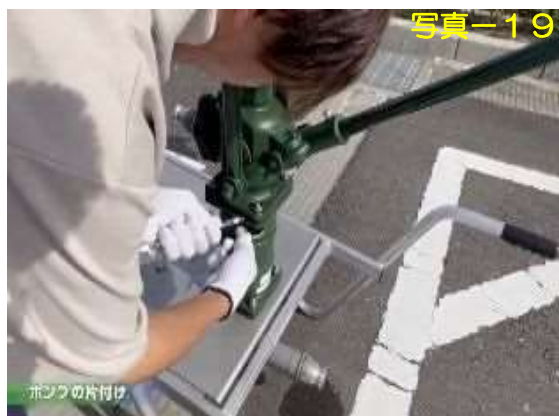
ボルトナットを外します
