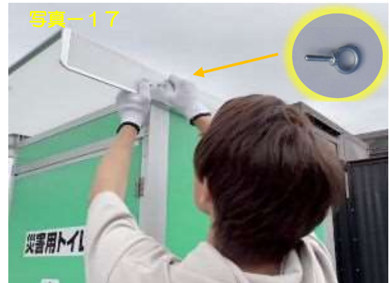
穴を確認してアイボルトを取りつける
