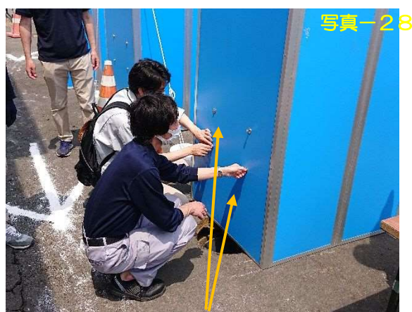
建屋外裏側ナット
