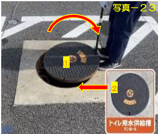
トイレ用水供給槽鉄蓋
