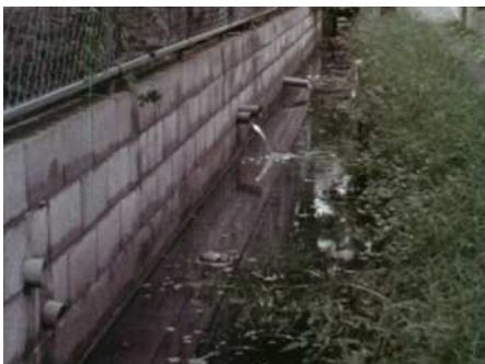
(下水道整備前)
