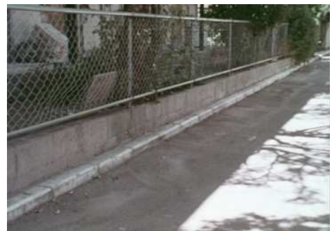
(下水道整備後)
