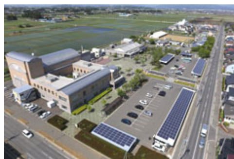
東松島「絆」カーポートソーラー
