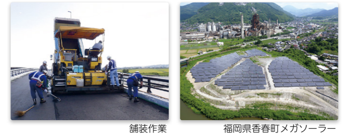
舗装作業 福岡県香春町メガソーラー
