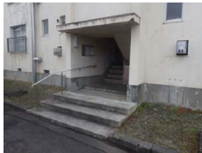
階段室入口(手摺あり、スロープなし)
