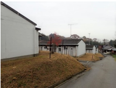
傾斜地に建つ準耐火住宅群
