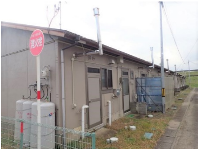
災害復旧工事が実施された準耐火住宅
