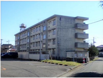
下浦住宅4号棟の全景
