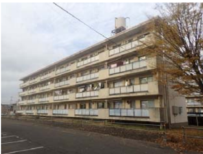
下浦住宅2号棟の全景
