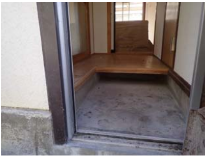
段差の大きな玄関
