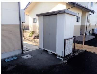
住戸別に設置された物置
