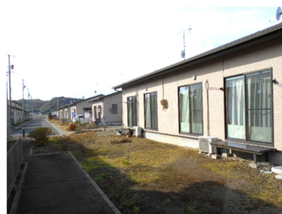
長屋住宅(2戸1、木造平屋)
