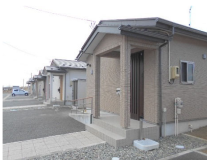
戸建て住宅(木造平屋)
