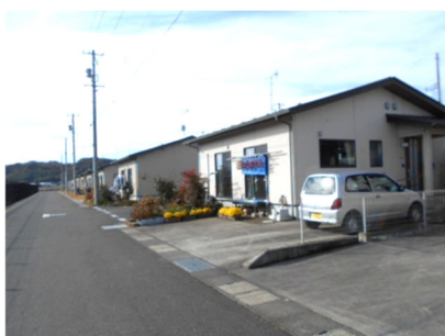
矢本西住宅の全景
