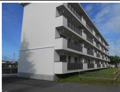
改善事業実施後の住棟
