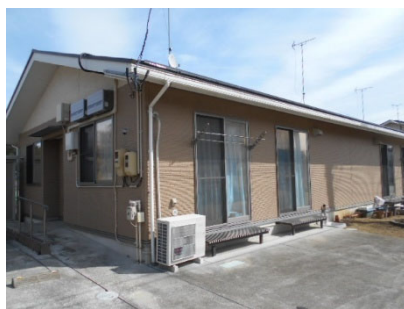
長屋住宅(2戸1、木造平屋)
