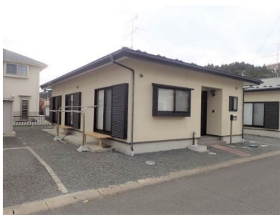
戸建て住宅(木造平屋)
