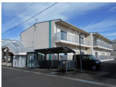
町浦住宅の全景
