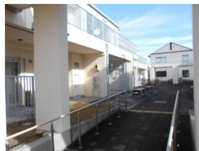
エントランスのスロープ
