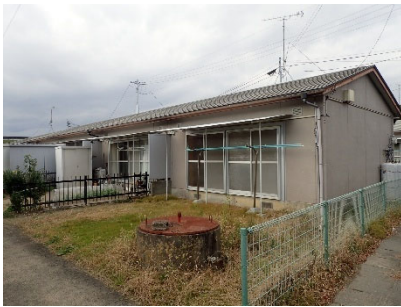
災害復旧工事が実施された住宅
