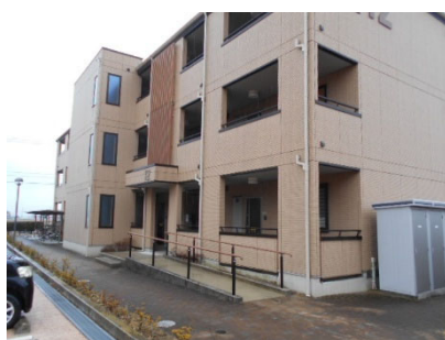
廊下・階段室側
