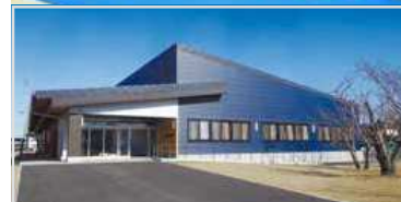
▲完成した体育館
