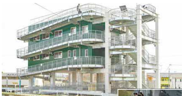
▲完成した避難タワー
