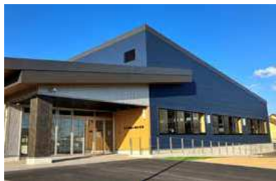
矢本運動公園体育館
