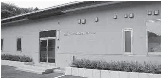
一般廃棄物最終処分場(大塩地区)
