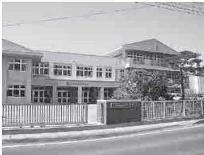
矢本第一中学校の新校舎
